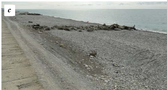
Р и с . 4 . Применение природного камня в российском гидротехническом строительстве: a – каменнонабросное берегоукрепление на правом берегу р. Нечеспсухо в пос. Новомихайловский Краснодарского края; b – каменнонабросная буна с траверсами в с. Небуг Краснодарского края; c – полуразрушенные каменнонабросные буны на участке Туапсе – Сочи
