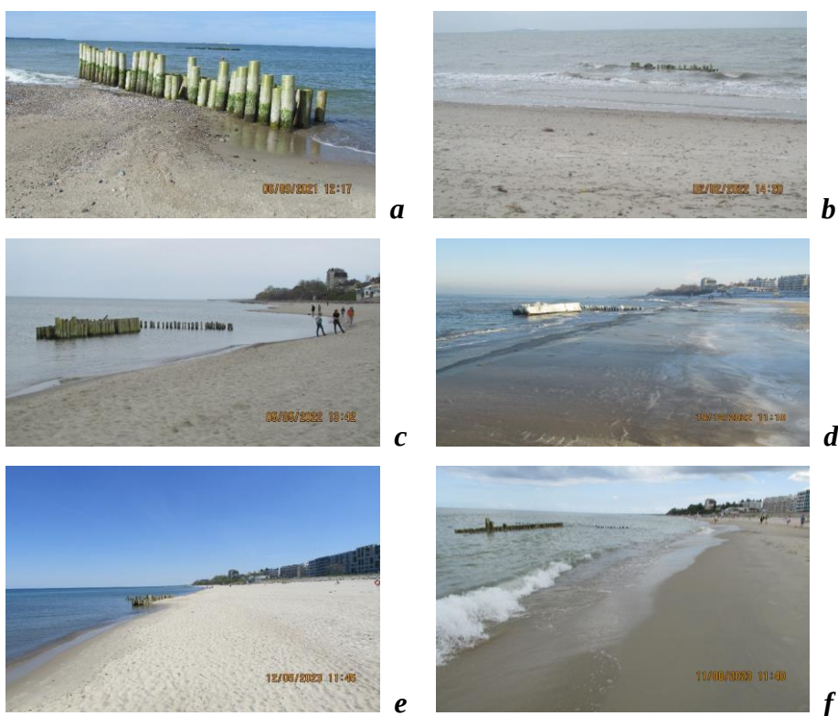
Рис. 4. Динамика пляжа после установки волноломов в 2021–2023 гг.: a – летняя аккумуляция, 06.09.2021 г.; b – сужение пляжа после экстремальных штормов, 02.02.2022 г.; c – состояние после штормового периода, 05.05.2022 г.; d – намыв пляжа в фазу затухания зимнего шторма, 19.12.2022 г.; e – восстановление пляжа весенним умеренным волнением, 12.05.2023 г.; f – сужение пляжа в связи с заметным ростом уровня моря, 11.08.2023 г. (фото – А. Н. Бабаков)
