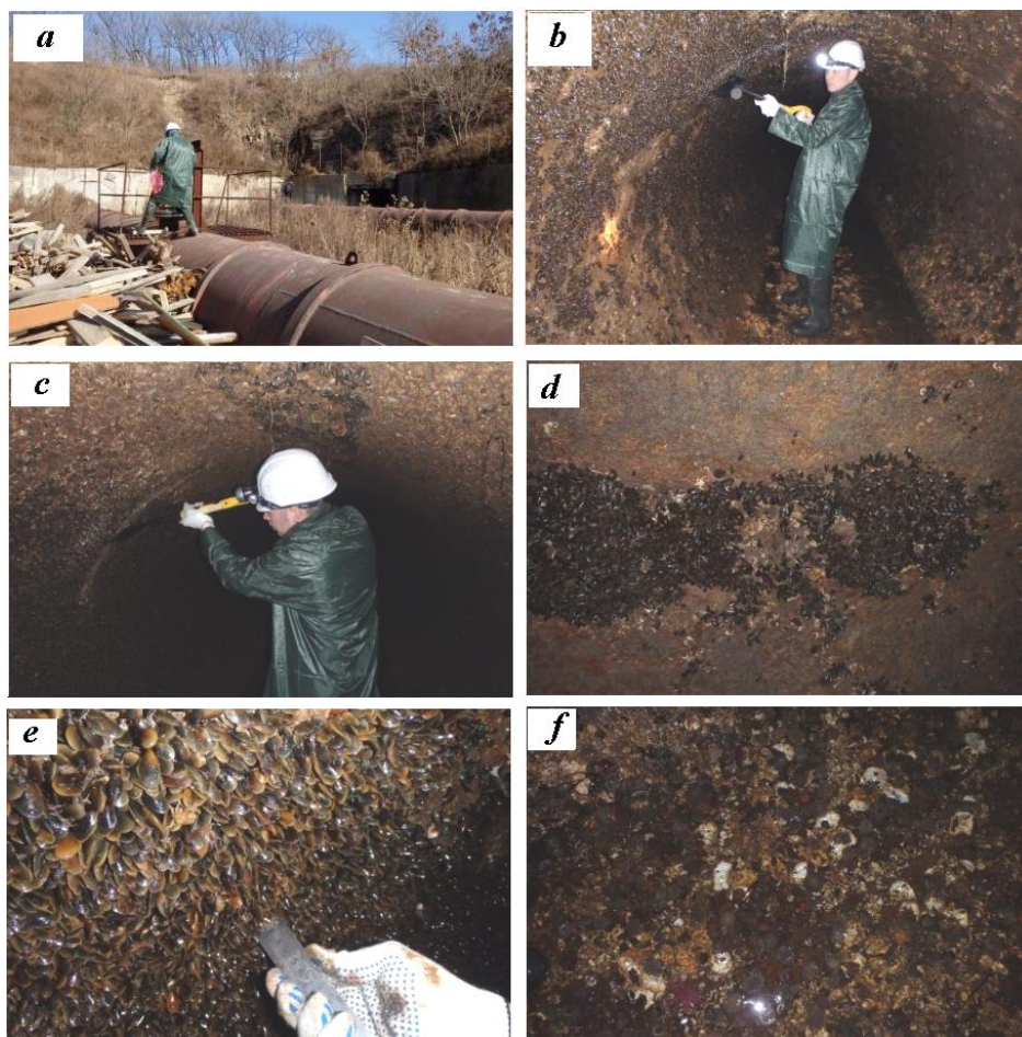
Р и с. 2. Процесс пробоотбора и общий вид обрастания водозаборного туннеля ВТЭЦ-2 на разных его участках: a – начало осмотра туннеля; b – обрастание сидящими многощетинковыми червями рода Hydroides ; c – пробная очистка стенки для оценки интенсивности обрастания; d – «щетки» мидий; e – сплошное обрастание туннеля мидией; f – устричное обрастание «низа» туннеля
